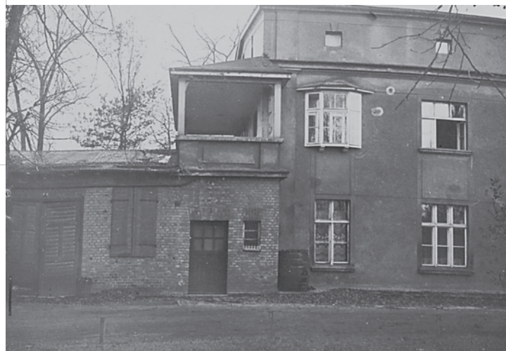
Zdjęcie fragmentu elewacji budynku po przebudowie przy ul. Jagiellońskiej 63/64. Fot., 1942 r. / APS, ANB, sygn. 4920.
