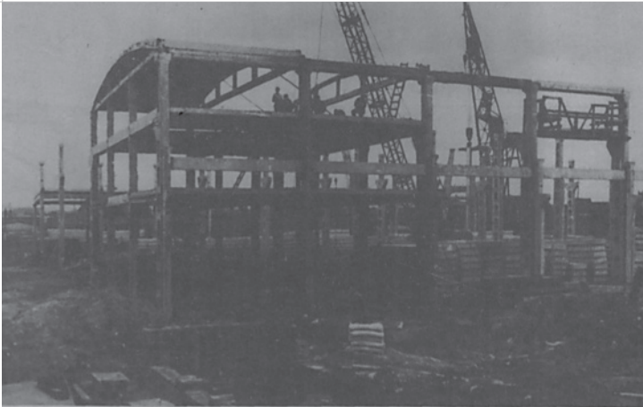
Montaż hali produkcyjnej Stoczni Remontowej „Parnica”. Fot. / APS, Zbiór Fotografii, sygn. 200/1201.
